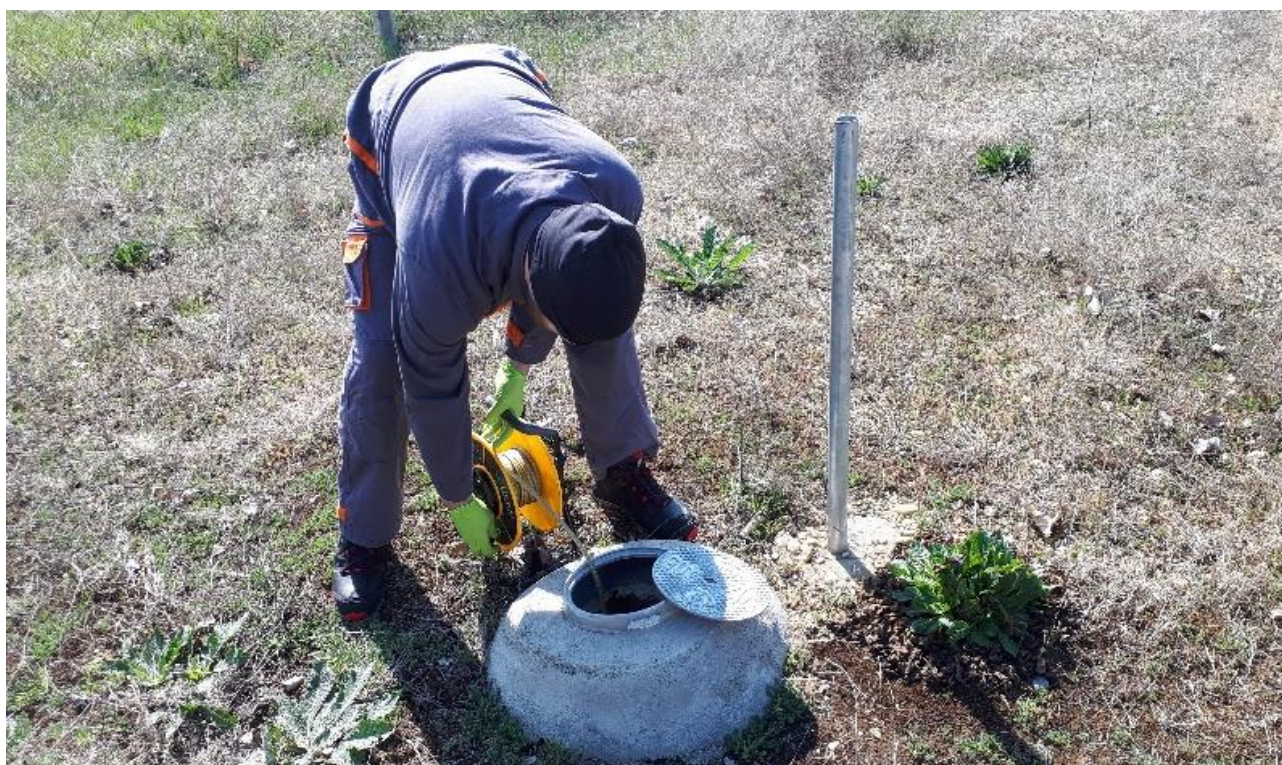
3.3-3. ábra: Az égető gödör (BA154) egyik monitoring kútja
